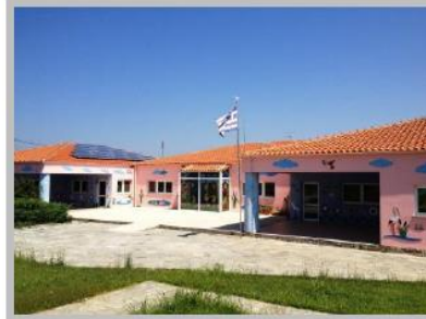
ΔΑ5-Β' Παιδικός Σταθμός Φερών
